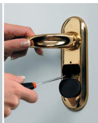
Con un cacciavite svitare le due viti che fissano il blocchetto.
