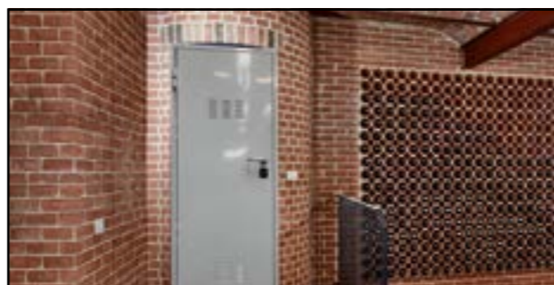
Puertas de sótano
